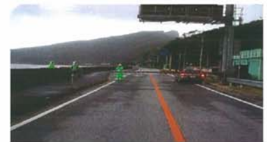
規制状況写真
